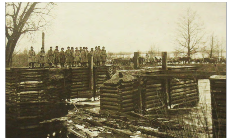
Шлюзы Белоозерского канала, 3 января 1916 г.
